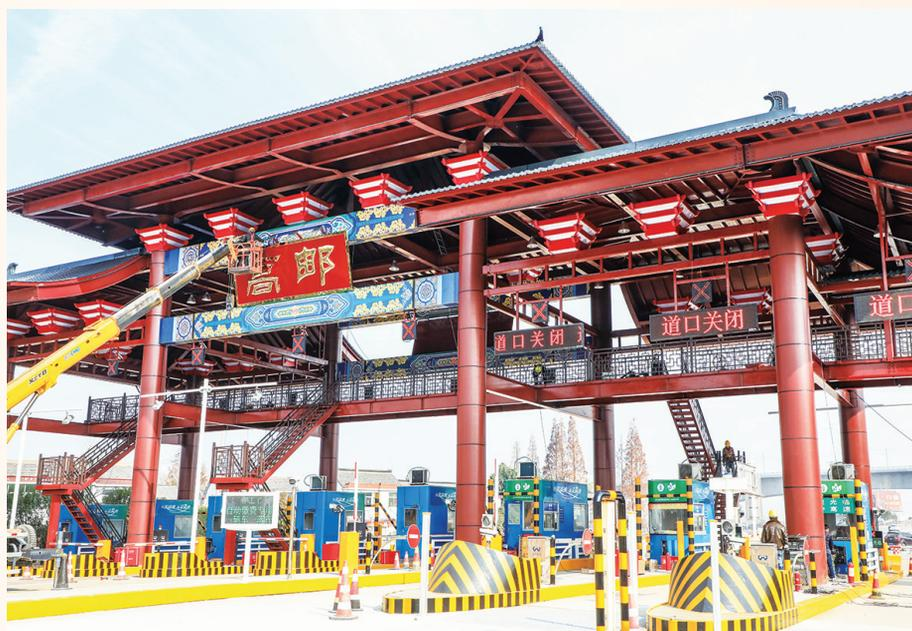
京沪高速高邮收费站大棚拆除重建工程于今年9月1日开始,经过3个多月施工,拆除了原收费站大棚,并新建了大棚主体结构。项目目前进入收尾阶段。新建的收费站采用钢框架结构形式,屋面采用仿古瓦,建筑总长51.5米,宽25.2米,高18.6米,主体基础部分采用柱下独立基础。
