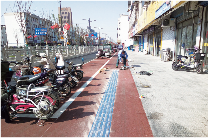
改造升级后的海潮东路路道变宽、多杆合一、路畅景美。为了进一步方便特殊人群出行,目前,市有关部门正在实施后续工程盲道铺设。该盲道首次采用不锈钢材质专用盲道模块,具有凹凸感强、感官更加明显、更加持久耐用等特点。图为工人正在铺设盲道。
