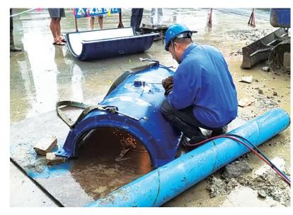
钢管,虽然是小面积破裂,但由于此处水 管为城市供水主管道,水压过大导致水管
