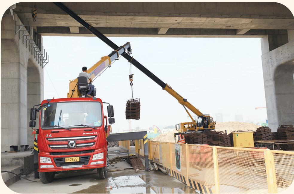
连日来,高邮高铁站施工人员顶烈日、冒高温,加班加点推进工程建设。目前,站台桩基工程已近完成,即将进入上部结构站房建设,预计今年12月站台主体完工。图为施工人员利用早晚凉施工的场景。
