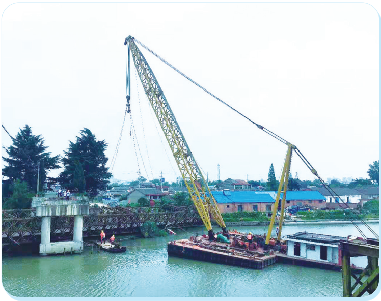
16日,通扬线上9座新建桥梁之一的三垛西桥,顺利完成便桥上部钢贝雷片拆除工作,下一步还将对桥墩进行拆除,为新桥建设做好保障。据了解,三垛西桥采取原位新建方案,目前,新桥已完成钻孔灌注桩10根,建设便道570米。图为当日拆除钢贝雷片现场。 爱辉 维祥 摄影报道
