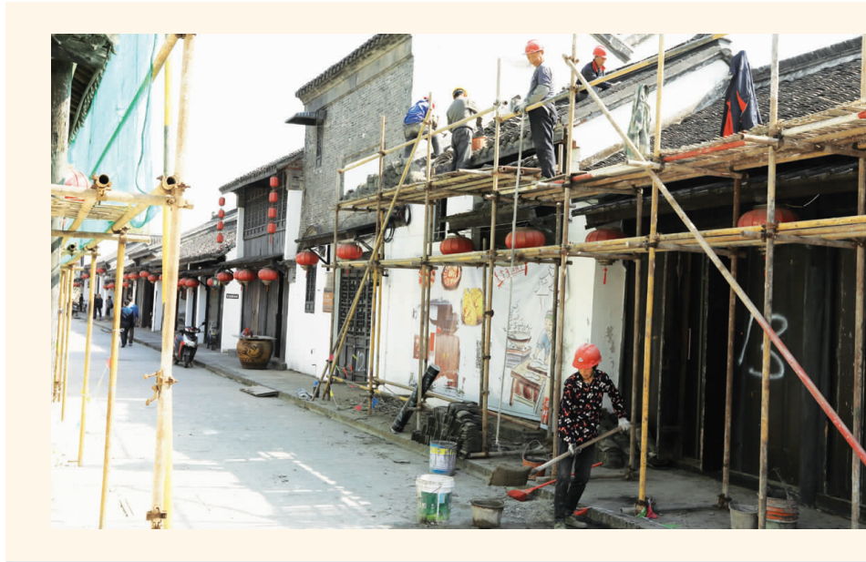
南门大街曾是明清时期高郵城最繁华的历史文化街区。为打造集餐饮、休闲、娱乐、旅游、古文化为一体的明清老街,市文旅集团从4月份开始对南门大街两旁建筑进行修缮,预计国庆期间重新对外开放。图为施工人员正在南门大街进行施工。
