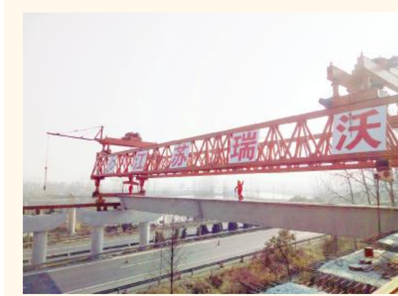
13日上午,333省道高邮东段改扩建控制性节点工程跨京沪高速公路大桥第一片箱梁成功架设。据了解,该预制箱梁长为35米,重约120吨,采用“大力士”盛华160型双导梁架桥机架设。预计整个跨京沪高速公路大桥箱梁全部架设完成需要两天左右时间。图为第一片箱梁横跨高速的雄姿。 葛维祥 摄
