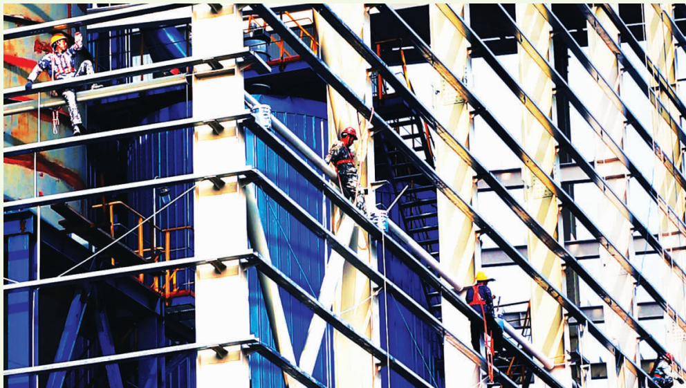
由天津泰达环保公司投资建设的高邮生活垃圾焚烧发电PPP项目,经过一年多施工,目前已进入设备安装调试阶段,预计下月完工并可试产。项目投产后年发电量将达9000多万度。图为施工人员正在施工的场景。 王林山 摄
