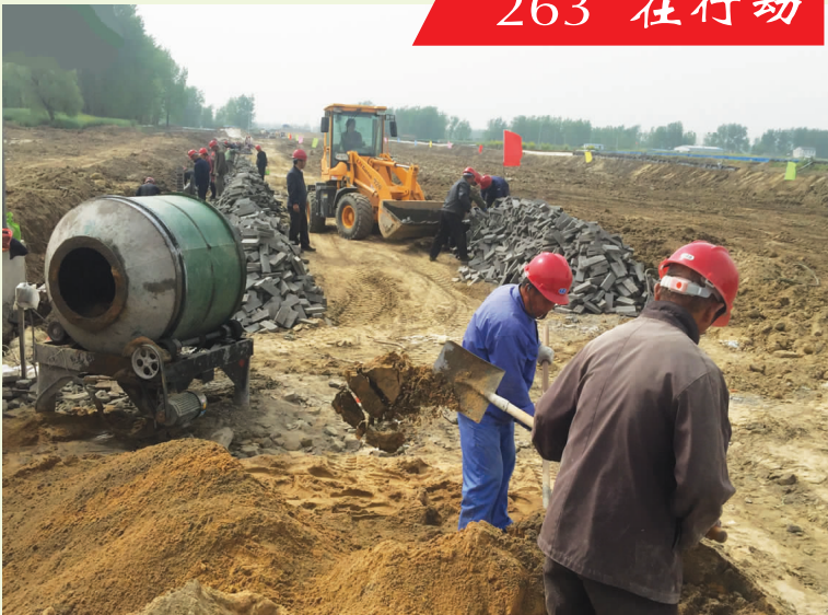
为解决我市东北部乡镇原有污水处理设施标准偏低、管网建设滞后、运营能力缺乏等问题,我市兴建临泽、三垛、卸甲3座污水处理厂,以提高东北部乡镇污水处理能力,改善水生态环境。图为卸甲污水处理厂项目建设现场,工人们正在抓住晴好天气紧张施工。 肖州 摄影报道
