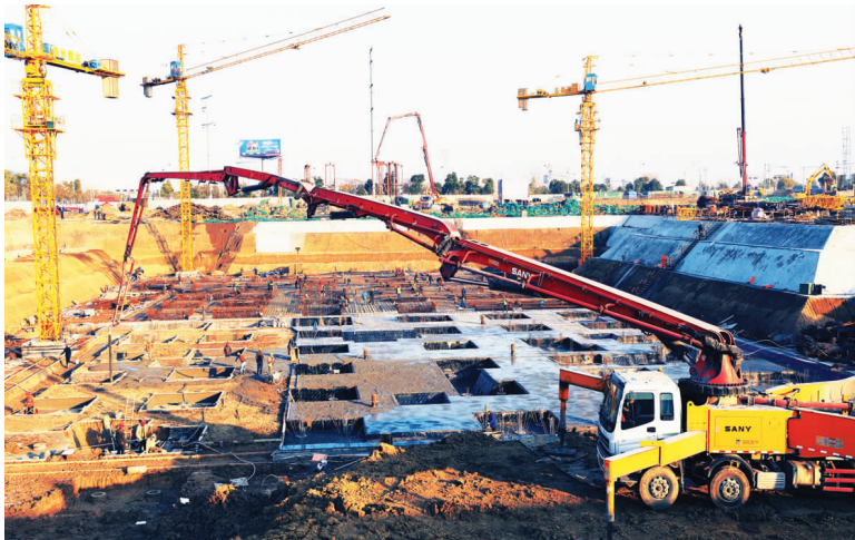
金奥城市综合体项目是我市去年城建十大工程之一, 总投资 20 亿元, 建成后楼宇高度约 200 米, 为高邮第一高楼。目前, 大楼地基已完工, 其他建设项目正有序推进, 预计整个工程建成需要两年时间。图为施工队正在完善底层建设。王林山 摄
