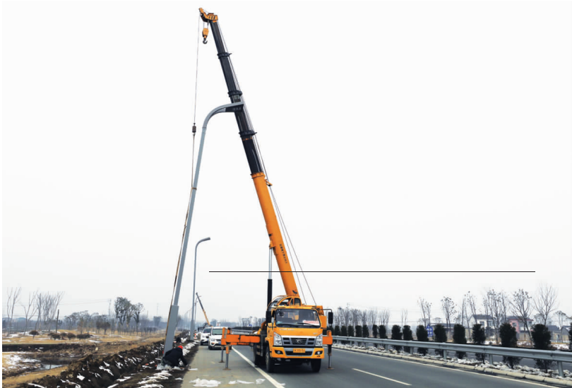
611 省道贯通后，我市对境内近 8 公里路段进行全面亮化，并对该路段三节点景观进行进一步打造，预计工程将于今年春节前完工。图为市交投公司施工工人正在施工的场景。
