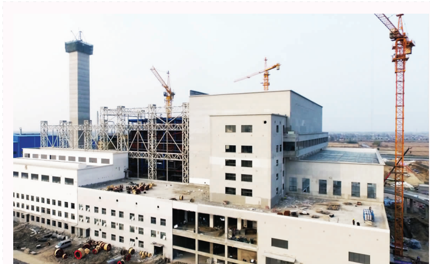
市生活垃圾焚烧发电 PPP 项目,经过 10 个多月的施工建设,目前主体结构已竣工,土建工程已完成 85%,屋面网架工程正在紧张施工。今年 10 月 25 日 1 号焚烧一余热锅炉水压试验一次性成功,近日汽轮发电机组又顺利扣缸,预计明年春节后进行试产。图为项目建设现场。
