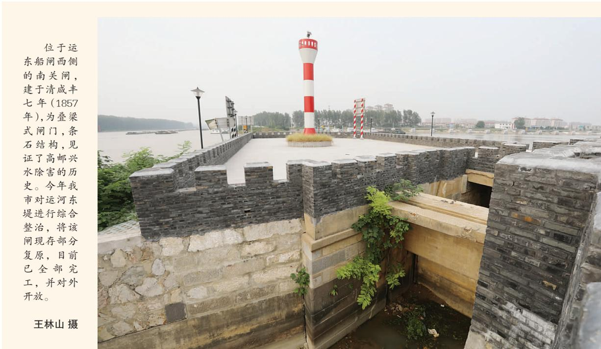
位于运东船闸西侧的南关闸,建于清咸丰七年(1857年),为叠梁式闸门,条石结构,见证了高邮兴水除害的历史。今年我市对运河东堤进行综合整治,将该闸现存部分复原,目前已全部完工,并对外开放。
