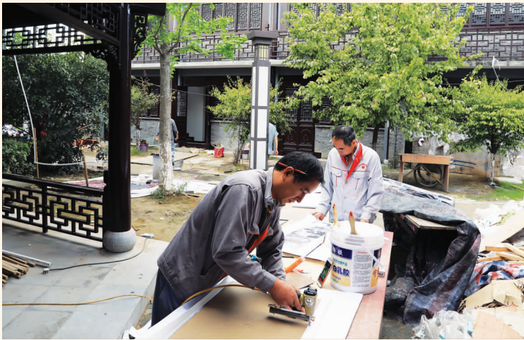
位于孟城驿后侧的中国集邮家博物馆将于本月28日对外开放。自今年6月施工人员对室内进行装修以来,目前工程已进入扫尾阶段。该馆主要收集全国各地收藏家们展出的我国早期集邮家和当代全国集邮联合会收藏的集邮品,以及集邮用品、集邮成果。图为布展人员正在紧张施工中。
