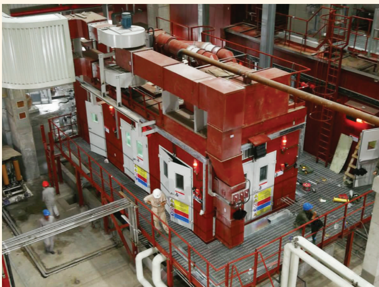
江苏国信高邮燃气热电联产项目一期工程总投资11亿元,建两套100MW级燃气蒸汽联合循环热电联产发电机组。目前,项目建设正有序推进,预计今年可建成发电、供气、供热。图为热电联产发电机组项目核心部位正在安装。
