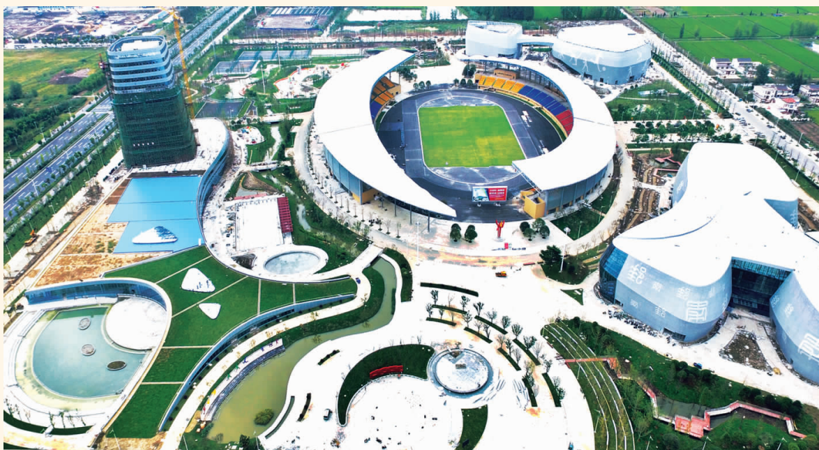
市文体中心自开工建设一年多来,各项施工进展顺利,目前整个工程已进入室内装修和周边环境美化阶段,预计10月28日可对外开放。图为文体中心航拍镜头。
