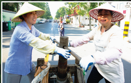
掏沟女工趁早凉疏通地下管网
