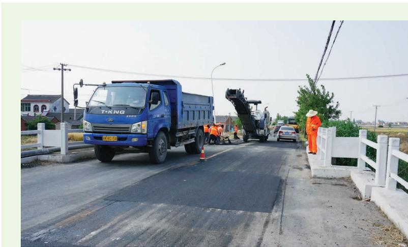
经受冬春冰冻雨水侵蚀及重载车辆碾压,县道路面出现翻浆、块裂、沉降等病害。从5月上旬开始,市公路站组织专业养护公司对辖区内县道公路沥青路面病害进行集中修补,此次修补涉及10条县道,修补面积达2.2万平方米,截至目前,该项修补工作已全部完成。图为县道甘武线路面病害修补现场。
