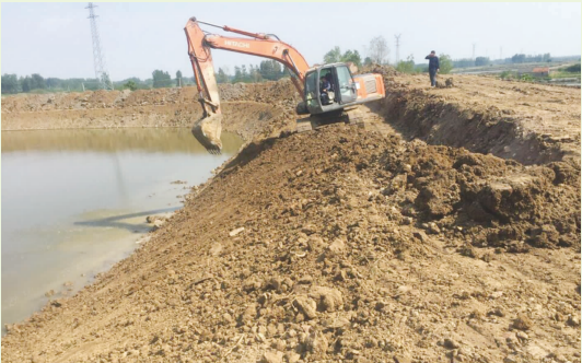
送桥大联圩加固施工现场
