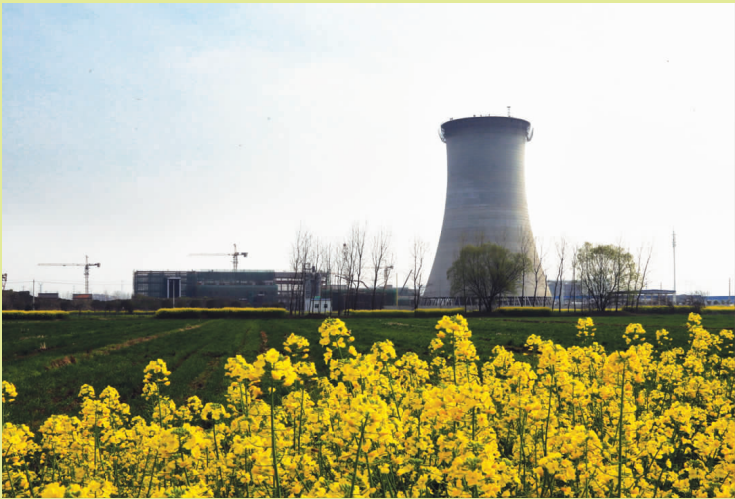
江苏国信高邮燃机热电联产项目自开工以来,已建成生产厂房和冷却塔主体工程,并完成两台锅炉受热模块、两台燃气轮机安装等工作。预计该项目今年三季度可建成投产。图为正在建设中的燃机热电联产项目工程现场。
