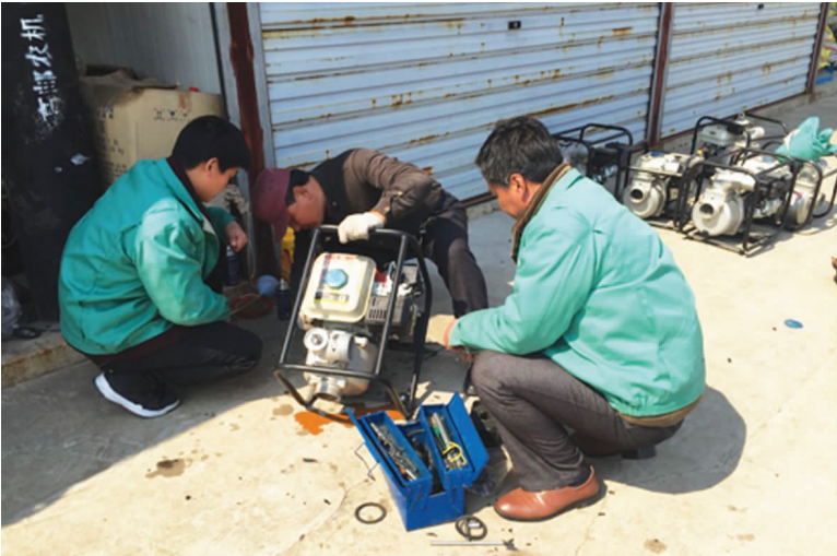
日前，市农机局机电灌排所组织技术人员，对备存防汛的流动汽油机泵进行了逐台检查、维修、保养，确保机泵处于良好状态。图为维修现场。贾海涛 业斌 摄影报道
