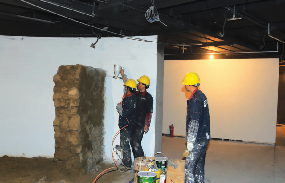
抗日战争最后一役纪念馆副馆装修目前已完工,正在进行展厅布展,预计下月 3 日前完成,旨在通过将抗战教育和自然景观有机结合起来,丰富红色资源,使其成为具备瞻仰、悼念、文化、休闲等多元功能的展厅。图为施工人员正在进行布展。 王林山 摄
