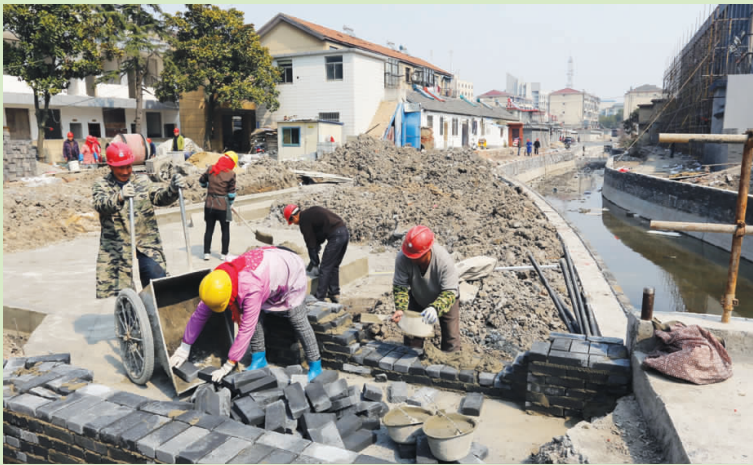
去年下半年，我市对玉带河周边环境进行综合整治。目前河道护坡、桥梁涵洞等工程已进入扫尾阶段，施工单位正对两岸绿化、亮化进行施工，预计4月中旬完工。 图为施工人员正在建设凉亭。 王林山 / 摄
