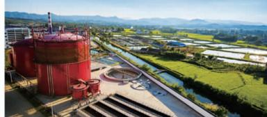
用曲酒酿造过程中产生的有机废液、废水发酵产生沼气，沼气燃烧锅炉产生高压蒸汽发电，发电后的余热用来酿酒。酿造过程中产生的废糟烘干后粉碎作为饲料。曲酒酿造车间的屋面全部安装太阳能光伏发电，形成了一个完整的全生态循环经济模式。
