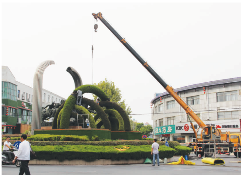
连日来，城市绿化部门对城市道口节点绿化进行整修增绿，以扮靓城市，喜迎国庆，为“四城同创”添彩。图为园林绿化技术人员正在东门广场吊装“绿色彩虹”。
