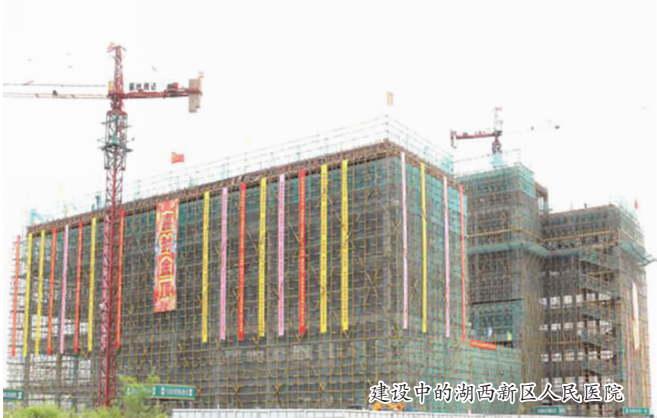
建设中的湖西新区人民医院
