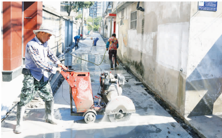
今年，我市投入近 4000 万元对 105 条后街后巷进行维修改造，预计 11 月底所有工程全部结束。图为施工人员正在进行作业。 王林山 / 摄
