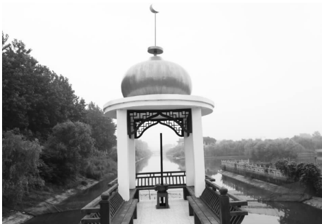
菱塘回族乡在实施水利工程项目时,将民族文化元素融入其中,使一座座具有回族伊斯兰特色的水工建设点缀在乡村的河塘河道旁。图为坐落在双庄河民族风光带旁的一座富有民族风情的水工建筑。陈兵 殷朝刚 摄影报道
