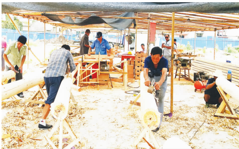
高邮州署重建工程今年7月中旬正式启动，将在原市政府内复建正堂、六科、仪门、侧门、广场、后花园等建筑设施。目前，该工程在加紧推进，预计国庆节前完工。图为施工现场。
