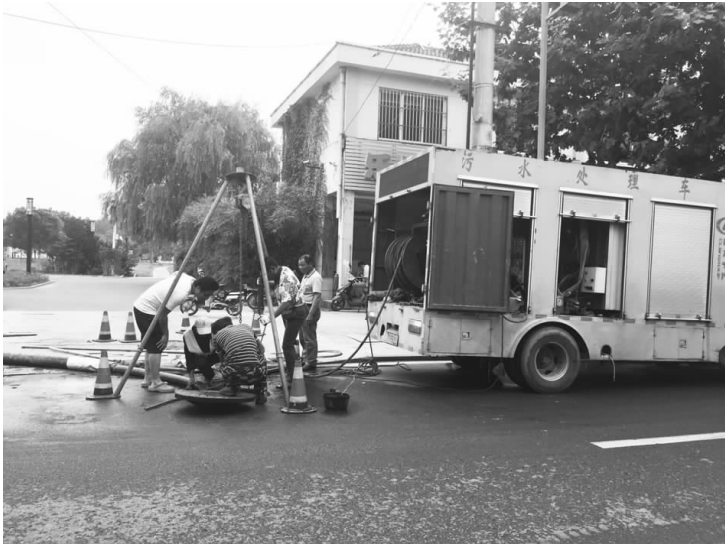
连日来，市水利部门组织人员、机械对城区地下排水箱涵、低洼积水点地下管道及主干道上的窨井一一进行排查、疏通，以防暴雨再次来袭。
