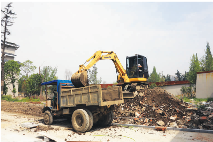
人民公园、抗战纪念馆及周边地块环境整治一期工程于去年底竣工,目前二期工程规划已“出炉”,计划 6 月底开工。图为部分施工人员已进入二期工程场地开始清理杂物。
