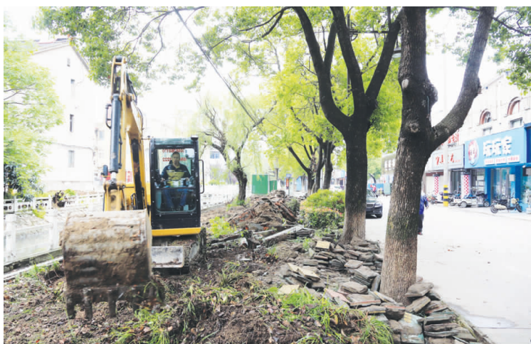
为适应城市发展需要，城建部门加大投入，及时对部分道路、街道、人行道进行扩宽及绿化美化。图为日前城建部门施工人员对孟城路的人行道、绿化区进行改造的场景。
