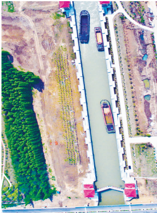
运东船闸自今年 1 月 20 日试通航以来,每天的船舶通过量近 3 万吨,年船舶通过能力提高 7 倍,货运周转量提高 2 倍,改变了以往“船等闸”的拥堵现象。
