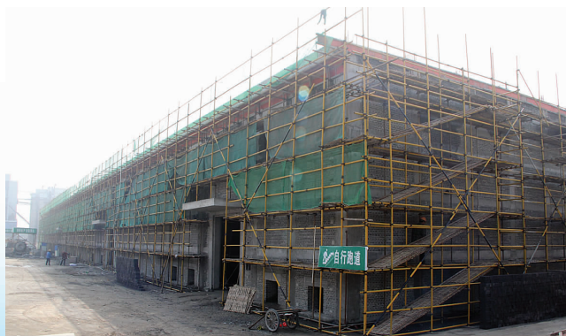
三垛粮库新建高大平房仓正加紧施工,将在夏粮收购中投入使用。
