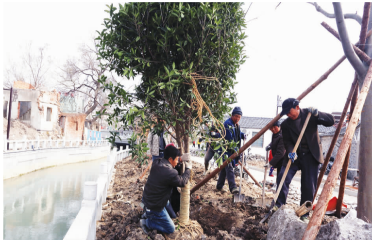
当前,全市上下正掀起为秦邮大地再添绿植热潮。记者昨日在市河二期扫尾工程现场看到,工作人员正在市河两岸栽植树木,绿化市河。 王林山/摄
