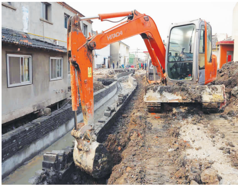
去年10月中旬,长生大沟、承志河整治改造工程正式启动。目前,该区域整治拆迁工作进入尾声,施工单位已进入长生大沟施工现场。
