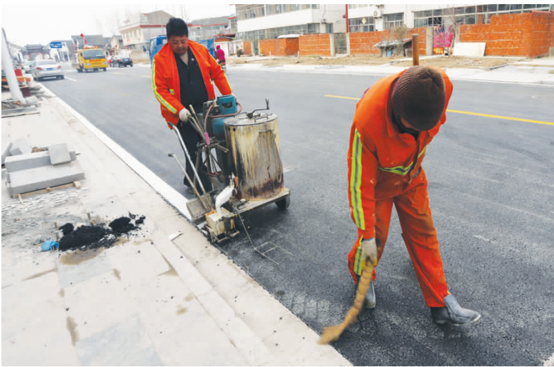
为连贯城南历史街区,去年我市对馆驿巷实施改造,目前道路路面部分已全部完工,正在进行道路绿化和配套设施安装,不日将全面通车。图为施工人员在施划交通提示线。 林山 摄
