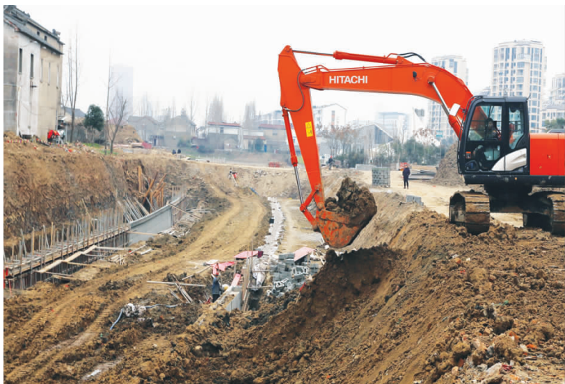
为确保南水北调输水干线水质达标，实现我市“清水活水、不淹不涝”宜居城市的建设目标，去年10月，我市对南澄子河（盐河至外环路段）水环境实施了综合整治。目前河道疏浚工程已全部结束，施工单位正在进行岸堤绿化和景观亭等设施施工，预计3月份完工。图为施工场景。
