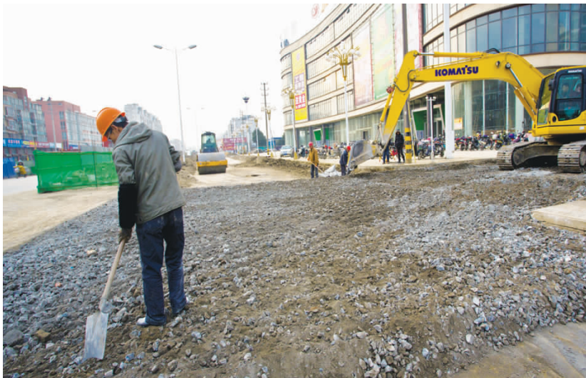
秦邮路主辅分离及环境综合整治民生工程经过3个月的施工，目前雨污水管道及地下各种管道配套设施土建工程已经完成70%，道路恢复建设工程已完成30%。预计整个工程4月中旬完工。图为道路铺设施工现场。
