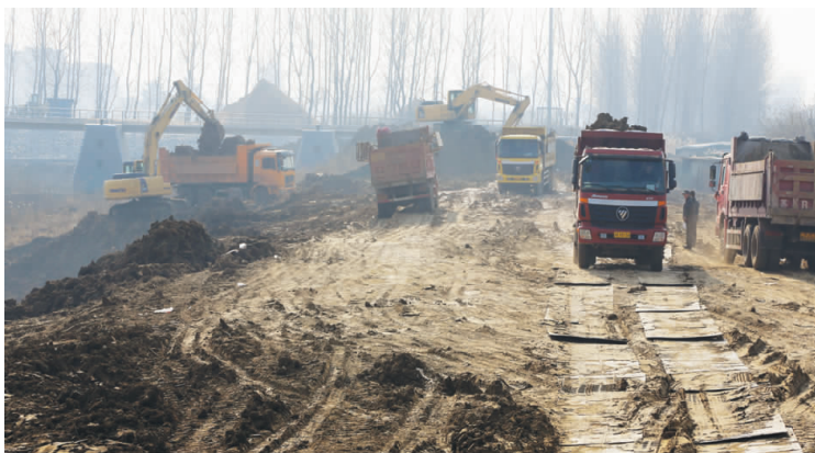
今年城建十大重点项目之一的船闸北路工程，全长 920 米、宽 18 米，于 10 月开工建设，建成后将与文游南路贯通。图为施工人员正在该路段施工。王林山 摄
