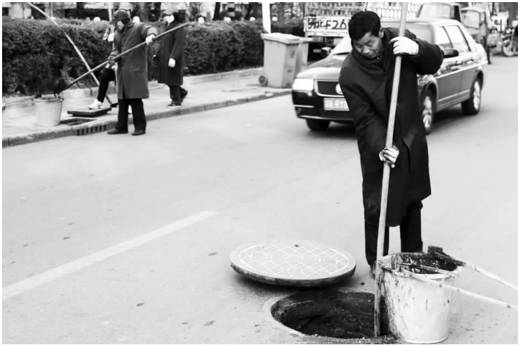
连日来，市掏污队分两批人员在城区大街小巷疏通下水道，美化城市环境，服务市民生活。图为掏污队员正在南海段清理下水道的场景。 王林山 摄
