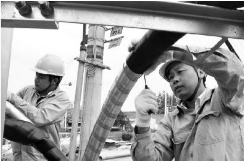
日前,市供电公司组织30多人对位于武安路的10千伏黄武线、10千伏124亿泰Ⅱ线双回杆线进行改造,为武安路东延连接S237让出建设通道。图为施工现场。
