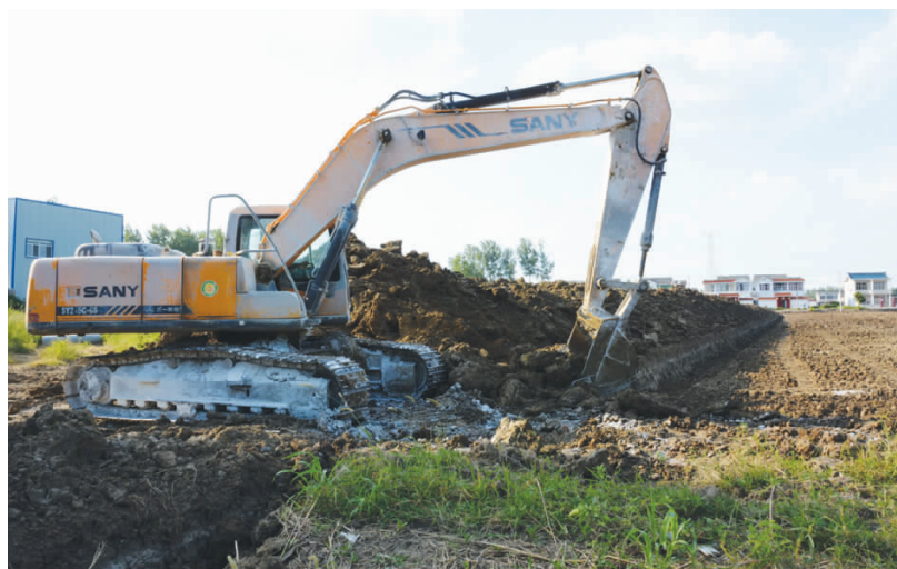
沿湖大道是我市连接扬州城区的重要交通道路。沿湖大道高邮段自8月份开工建设以来,相关部门、乡镇和施工单位攻坚克难,倒排工期,压茬推进,目前工程进展顺利。沿湖大道建成后,高邮到扬州只需要半个小时。图为工程施工现场。李久强 殷建荣 摄影报道
