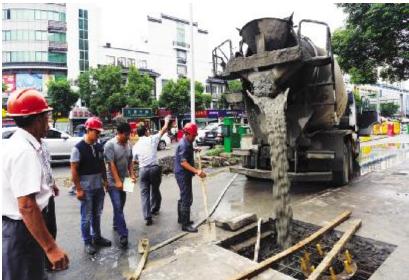
为进一步美化城区交通环境,规范各种车辆分道行驶行为,今年以来,我市不断加大城区主干道交叉路口渠化改造力度,有效提高了高峰期人流、车流通行率,缓解了交通压力。图为施工人员正在文游路与通湖路交叉道口进行渠化改造的场景。 王林山 摄
