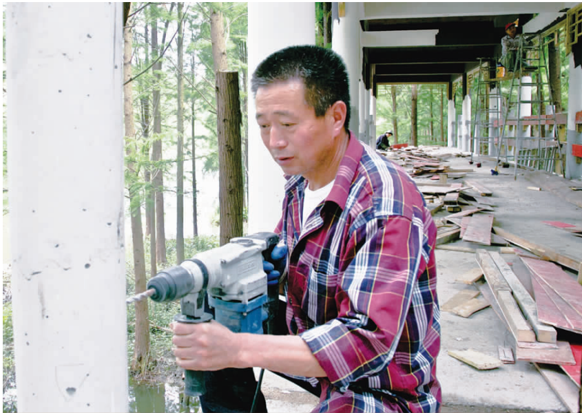
被列为全国优选旅游项目的清水潭度假区, 经过一年多投资建设, 目前首期生态中心工程已进入基础设施完善阶段。图为施工人员正在园区天桥段施工的场景。
