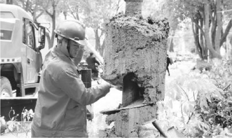
17 日，市供电公司组织 200 余人对龙虬镇区近 2.5 千米的 10 千伏及 400 伏线路进行改造，将原线路通道的 60 根 12 米电杆更换成 18 米电杆，以化解集镇道路两旁景观树与电力线路的“树线矛盾”，并增强对集镇的供电能力。 林华鹏 / 摄
