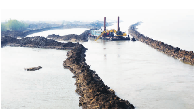
4 月底,高邮湖淮入江水道整治工程高邮段切滩工程已基本完成,有望 5 月底投入使用。整治后的水道行洪流量最大可达 12000 立方米/秒,可抗百年一遇的洪水。图为切滩工程施工现场。
