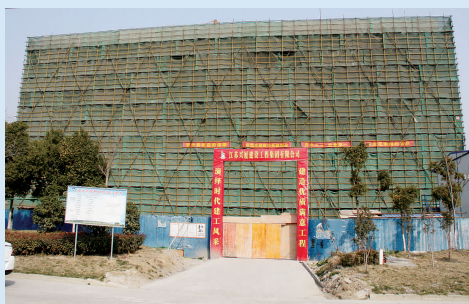
东方拓力项目现场
