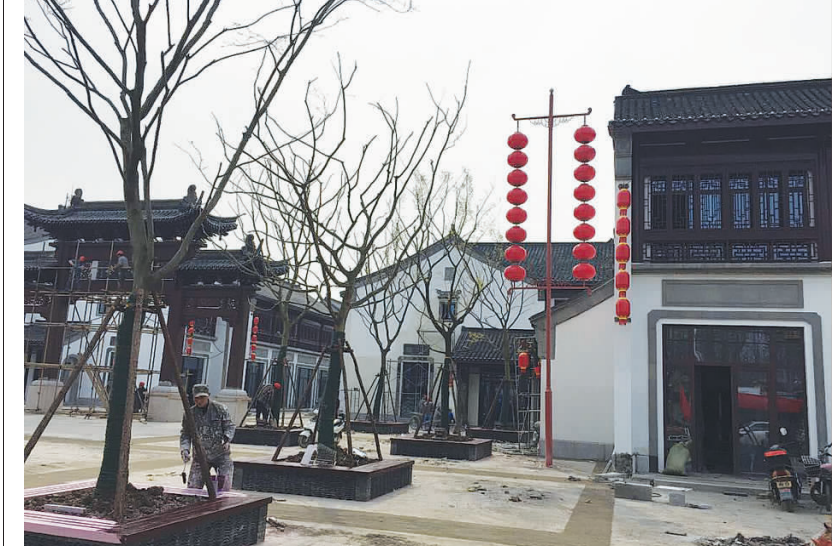
孟城驿二期工程历经一年时间建设已近尾声。目前,施工人员正在抢抓晴好天气做好扫尾工作,确保在“4·17”前竣工。图为施工现场。 郭玉梅 / 摄
