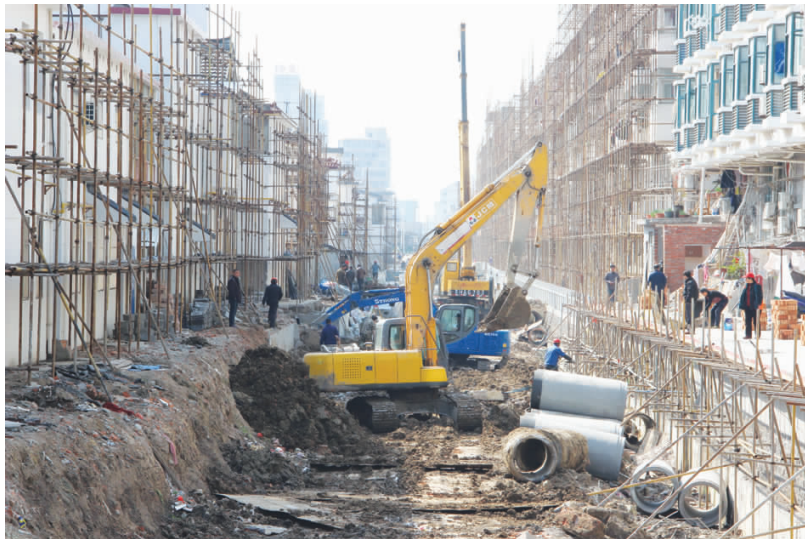
为打造“清水活水,不淹不涝”宜居城市,2014年下半年,市委、市政府决定对东门大沟进行综合整治。目前,管道截污、绿化景观、亭廊步道等工程正在建设之中。图为施工现场。 殷朝刚 摄
